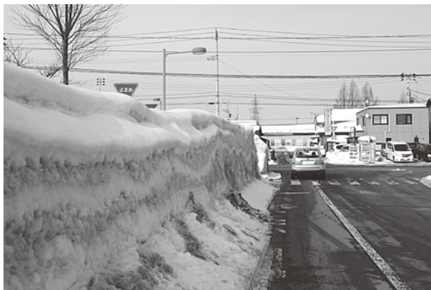
道路脇の雪の堆積で運転席から見えない道路標識
