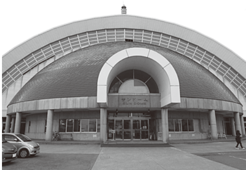
改修工事が行われる予定のサンドーム
